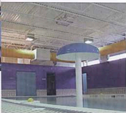
Fig. 1. Tekstilkanal med spalte. Her i en vinkel rettet imod glasfacaden.
