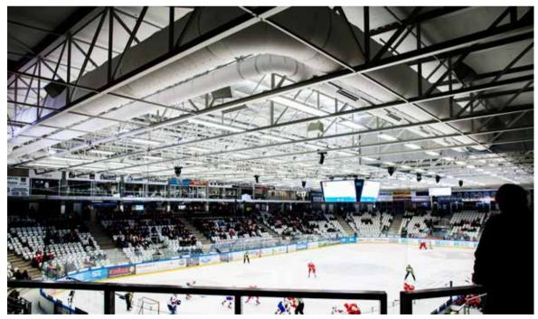
Une dispersion appropriée de l'air se fait sans courant d'air, minimise les congés maladie et augmente le niveau de confort. Elle a des effets positifs sur la durabilité des bâtiments et des équipements en éliminant la condensation et en évitant l'humidité et la formation de moisissures.
