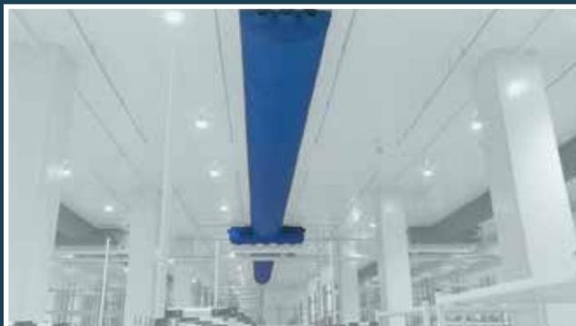
On les retrouve généralement dans les entrepôts en hauteur et les salles de serveurs. Les gaines textiles à section circulaire prennent très peu de place pour créer le flux d'air parfait. Lorsqu'ils sont conçus avec des projections directionnelles, ces profils de gaines permettent d'obtenir un mélange parfait et une dispersion uniforme de l'air en dépit de leur conception plate.
