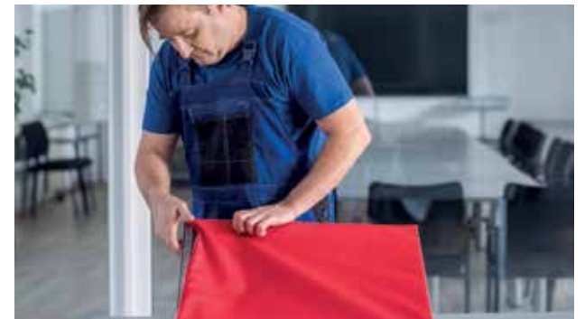
Pritvirtinkite kitą perforuotą medžiagą ant slėgio dėžės
