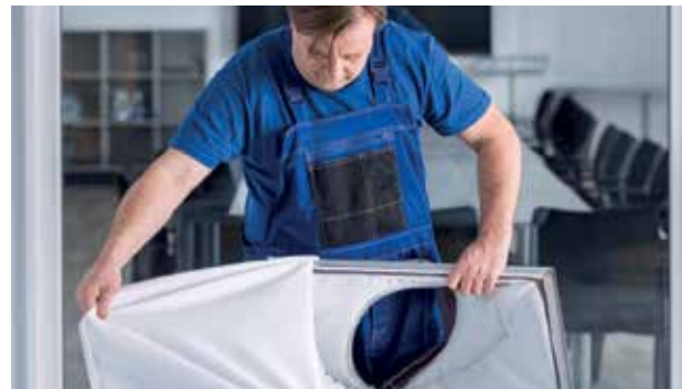
Odklejamy panel przepływowy
